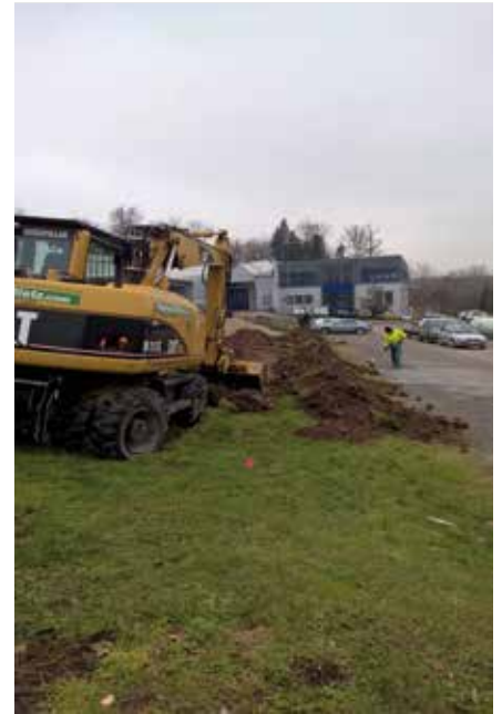
Les travaux ont débuté; sur la photo: l'agrandissement du parking pour les employés.
