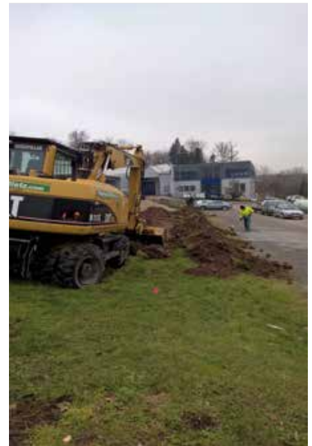
Die Bauarbeiten haben begonnen, hier zur Erweiterung des Mitarbeiter-Parkplatzes.
